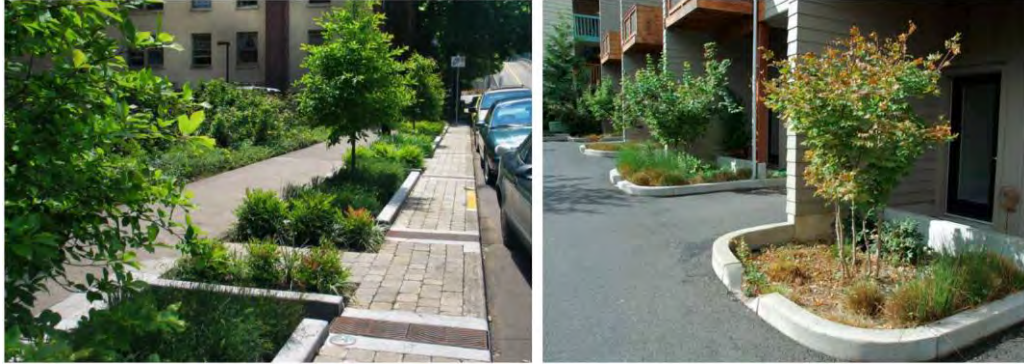
Figur 11. Exempel på nedsänkta regnbäddar. Vänster foto: City of Portland, courtesy Bureau of Environmental Services. Höger foto: Dagvattengruppen, Sweco
