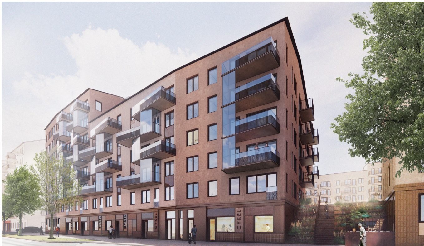
Vy mot Sjödalsvägen. Fasadens vinklar tas upp i balkongutformningen.
