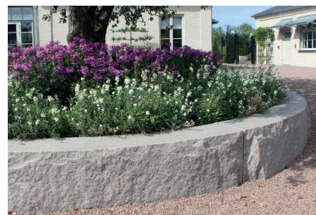
Murar - stödmurar i natursten runt de upphöjda planteringarna skapar rumslighet och blir stommen för bänkarna. Murarna utförs i granit av nordiskt ursprung som återfinns vid Sjödalsstorget och är ett hållbart val i linje med projektets miljömål. Sort av granit väljs för att rymma med gatstenen i markbeläggningen och kan med fördel också vara återvunnen.
