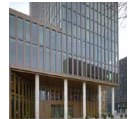
Referens arkad och sockel (Riverside hotel, David Chipperfield)
