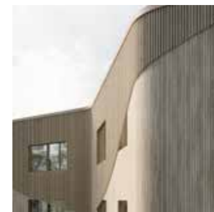
Lockläkten skapar former i fasaden (Arkitema)
