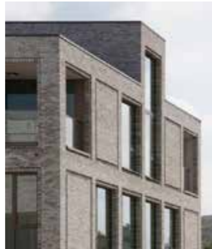
Tegelfasad med relief (be-Mine villa, UAU collectiv)
