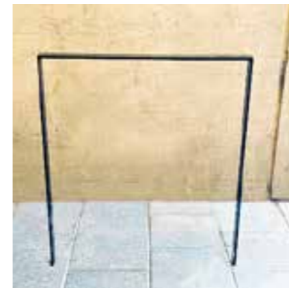
Enkla cykelpollare av stål möjliggör säker fastlåsning i ramen
