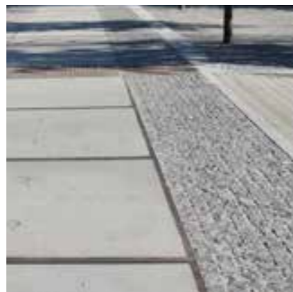
Stelconplattan gjuts i en stålprofil och kan vara 2x2 m.
