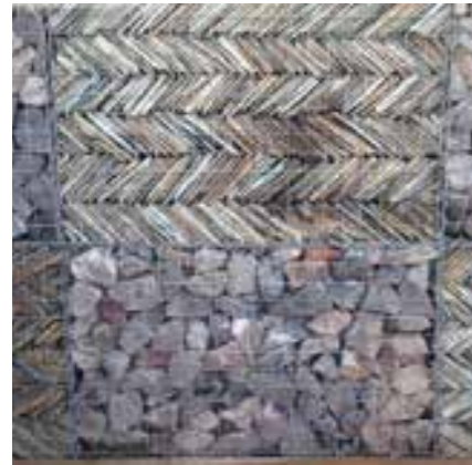
Enkla murkonstruktioner av återbrukat material från platsen
