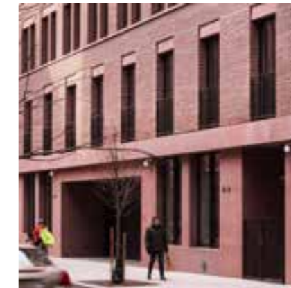
Markerad sockel i betong ton i ton med tegelfasaden (Bostadshus New York, David Chipperfield)
