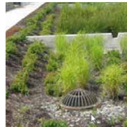
Vid kraftiga regn fylls bädden och breddas mot brunnen.
