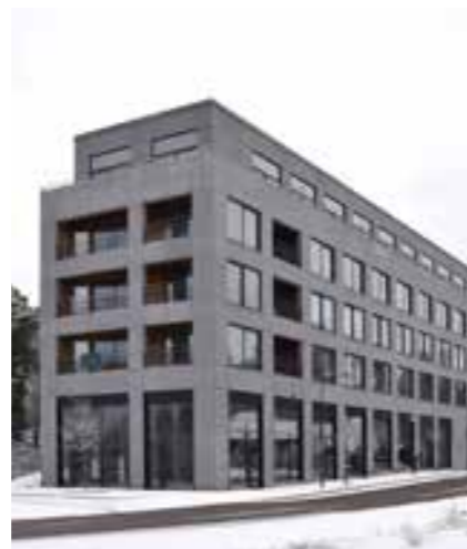
Referens betongfasad Kv Glommen (Scott Rasmussen Källander)
