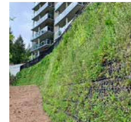
Höjder tas upp med gabionmurar. Lämpliga för klättrväxter eller vertikala odling
