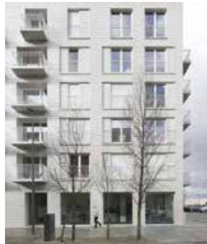
Betongfasad med relief (KAAI 37 Antwerp, aDVVT)
