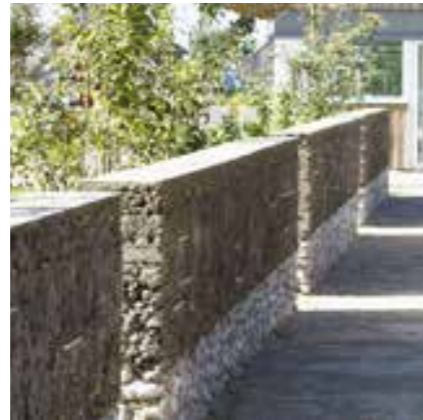
Muren blir rumbildande och ett karaktärsgevande landskapselement
