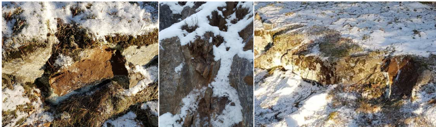
Figur 4. Exempel på den ställvis mycket rostiga berggrunden inom området. Till vänster och till höger vid provpunkt 2, i mitten vid provpunkt 6.
