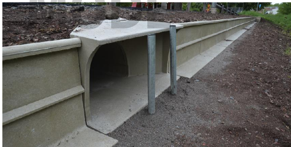
Figur 3. Groddjurspassage med ledarmar och tunnel (Temablad Natur - Groddjur, Trafikverket, foto Mats Lindqvist).
