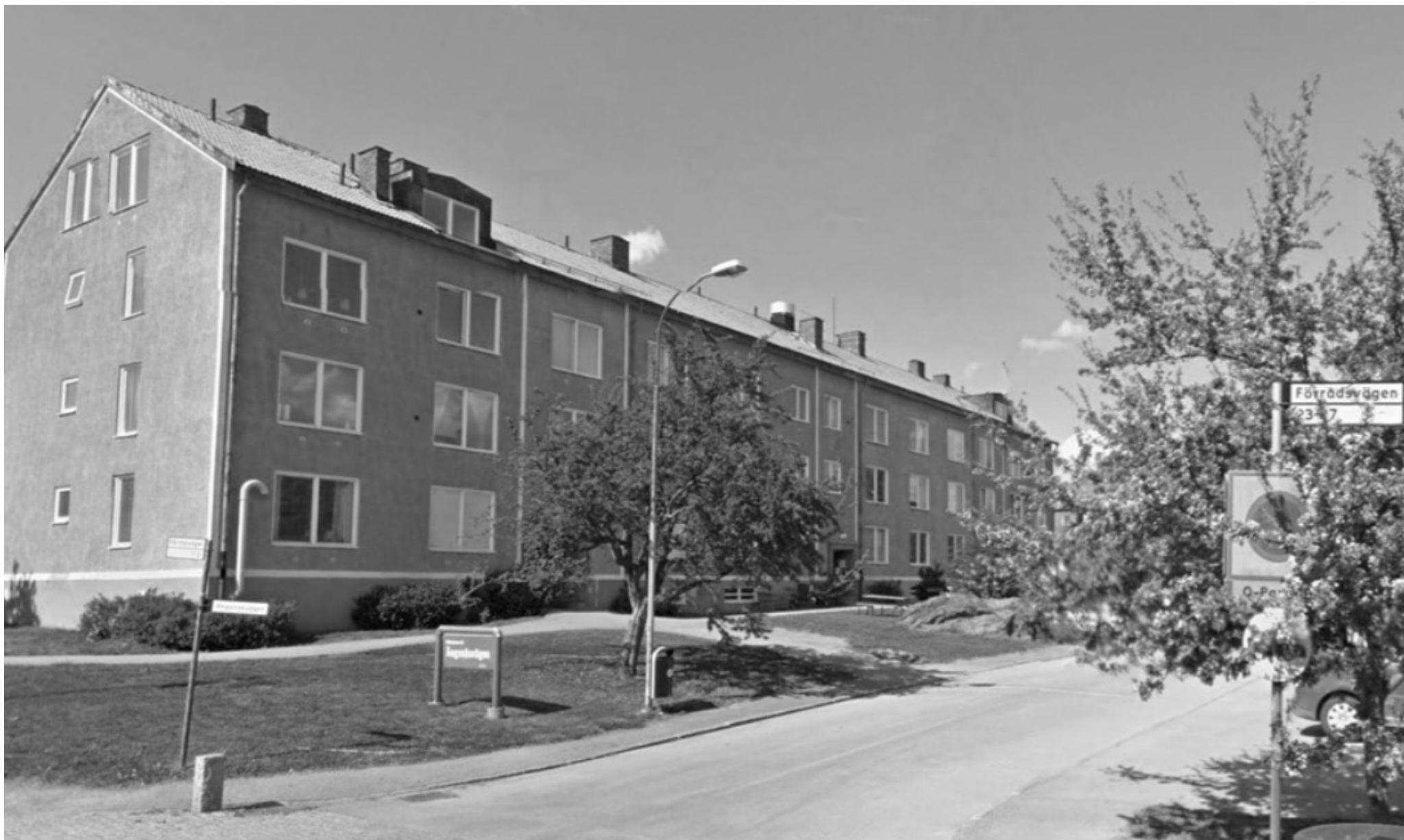
Bebyggelse längs Ängsnäsvägen. Byggnaderna ritades av Sture Frölén och följer grannskapsplaneringens planideal och folkemmets stiluttryck. Genombrutna lägenheter med generösa fönster. Bebyggelse i tre till fyra våningsplan krönt av sadeltak. Byggnaderna är placerad i parklandskap, indragen från vägen med generös förgårdsmark. Trafikseparerade gångstråk leder genom området.
