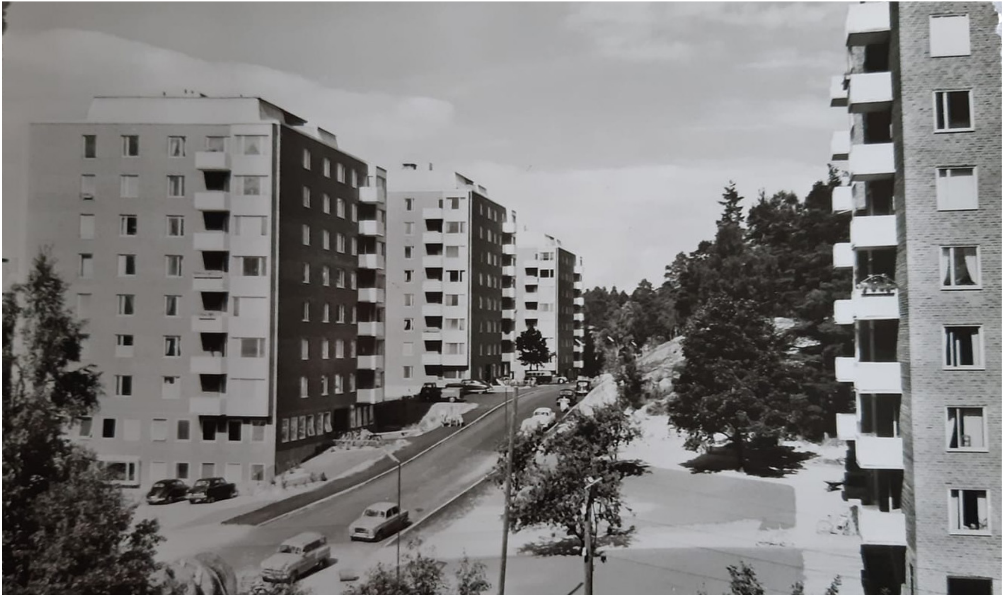
Bilden visar Södalsbacken med den historiska vägen som följer höjdpatriet. Blottade bergsknallar och skogsklädda partier är ett karaktäristiskt inslag i Södertörns sprickdalslandskap. Det lokala landskapet och naturen blev även utgångspunkt för utformningen av 1950-talets gröna rum. Bebyggelsen anpassades efter terrängen och naturpartier var en del av bebyggelsemiljöernas utformning. Källa: bild hämtad från Tradera
