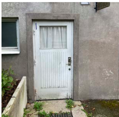
Ursprunglig dörr i trä med glasparti. Omfattning i natursten möter putsad sockelvåning.
