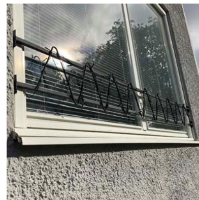
Tidstypisk smidesdetalj på fönster.
