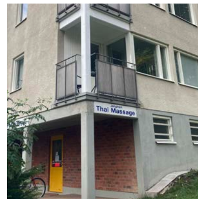
Uppbruten volym. Flera olika fasadmateriell samspelar. Indragna balkonger med tidstypiska smäckra fronter. Fasaden bakom balkong är inklädd i panel.
