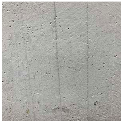
Brädformad betong
