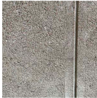
Slätputs samt markerade skarvar
