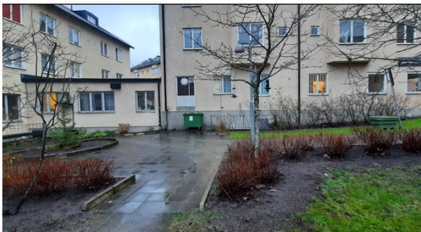
Figur 11 Takavvatning av bebyggelse på Fullerstatorget via hängrännor och stuprör.
