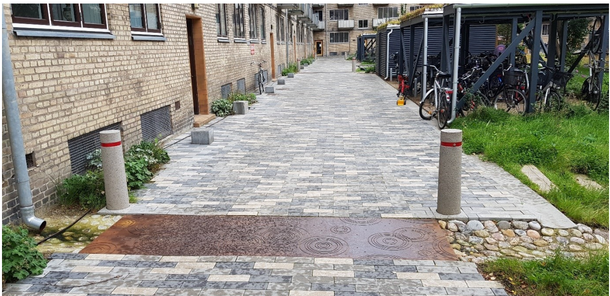
Figur 23 Exempel på en anläggning som leder vattnet från takytor (stuprör) till grönytor i Köpenhamn. (Bildkälla: Joakim Scharp)
