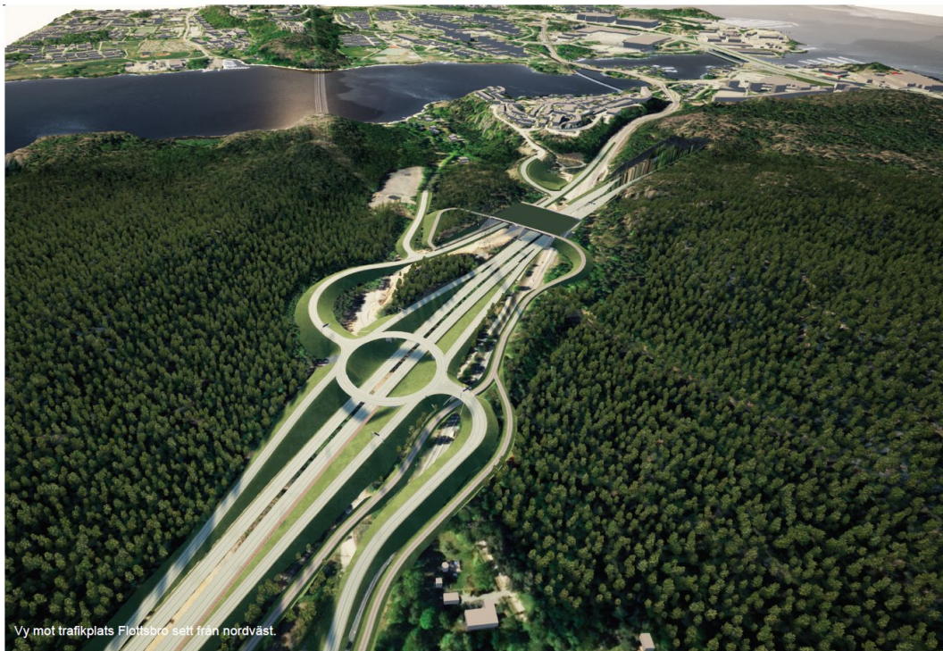
Figur 5: Vy mot trafikplats Flottsbro sett från nordväst. Bild: Trafikverket.
