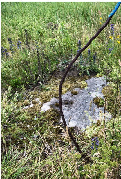
Figur 6. Ett armeringsjärn har pressats upp ovanför markytan ovanpå deponin. I bakgrunden blottas en mossbeväxt betonghäll.
