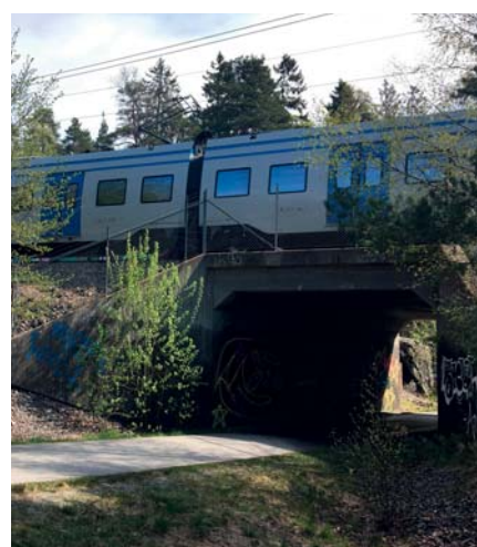
Gång- och cykeltunnel under järnvägen
