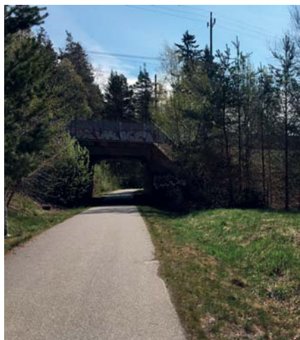
Gång- och cykeltunnel
