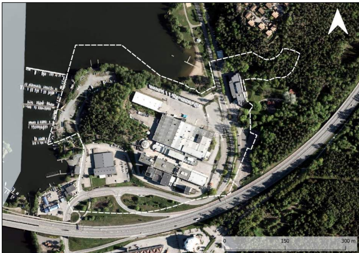
Figur 2-1. Flygfoto över planområdet vars utbredning har markerats med en vitstreckad linje. Bakgrundskarta: Ortofoto från projektportal.
