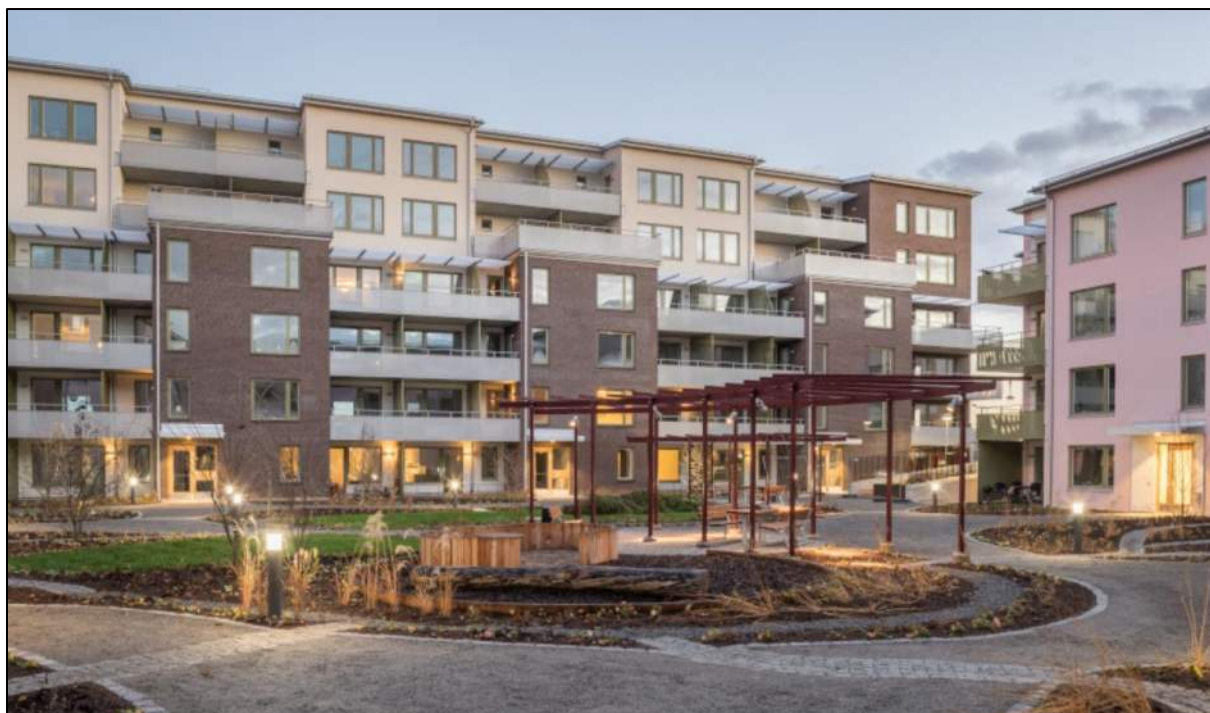
Figur 6-4. Exempel på gestaltning av innergård med avledning av dagvatten via öppna ränndalar till planteringsytor och grusade infiltrationsstråk. Källa: Uppsalahem, Områdesbilder Linnéhuset.
