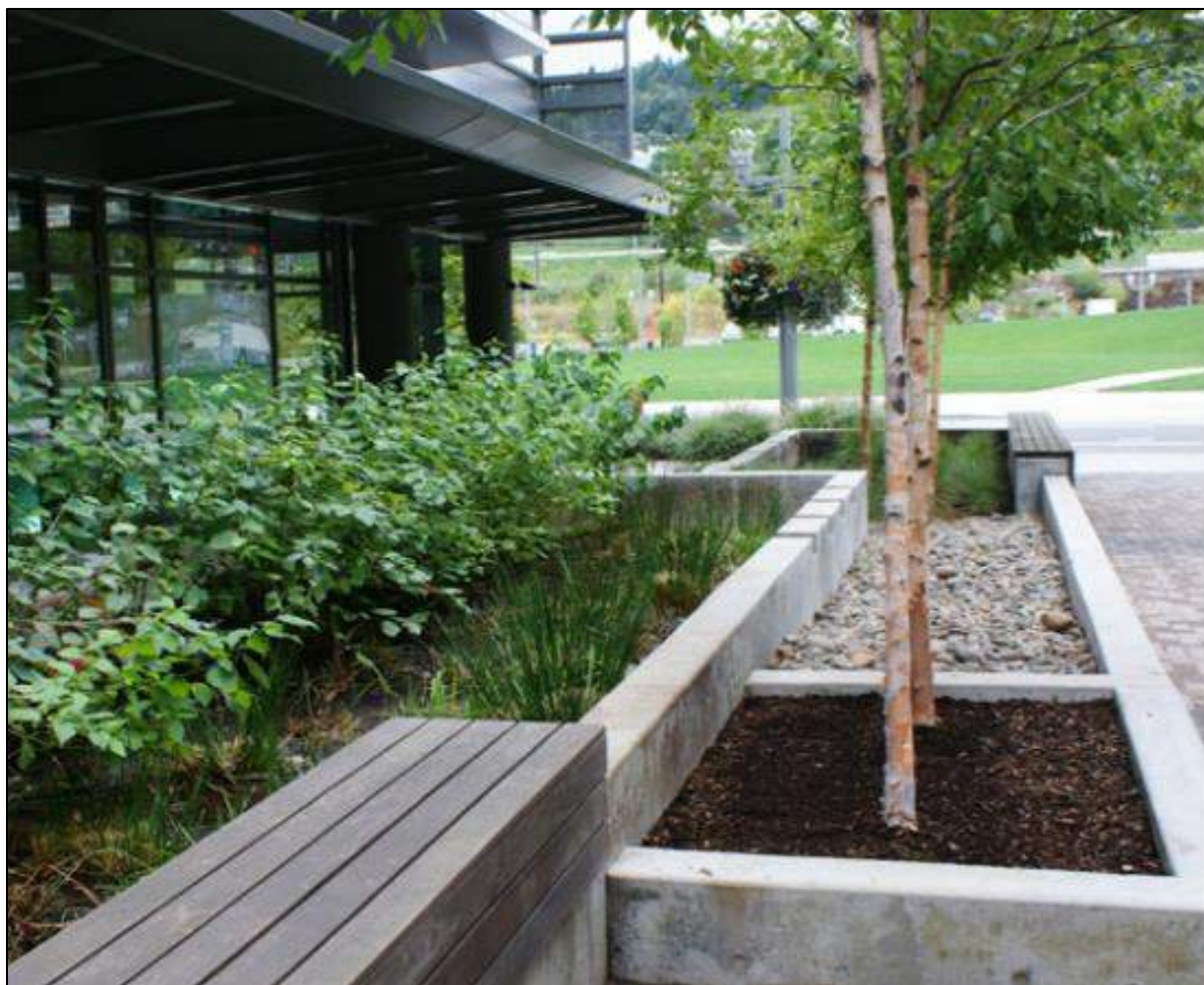
Figur 6-6. Exempel på dagvattenhantering i regnbäddar i anslutning till bebyggelse som också bidrar till gestaltningen av omgivande allmänna ytor. Bild hämtad från Haninge kommun (n.d.).
