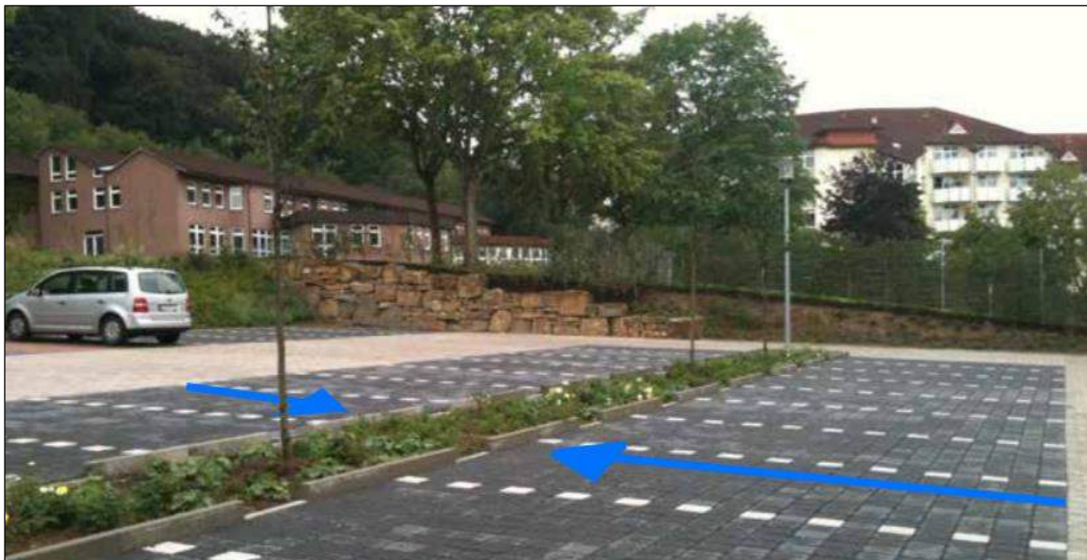
Figur 6-12. Exempel på utformning av dagvattenhantering inom parkeringsytor. Mellan parkeringsremsoerna anläggs ett vegetationsstråk där vattnet kan infiltrera. För ytterligare förbättrad effekt och reducerat volymbehov föreslås parkeringsytorna anläggas med genomsläpplig beläggning.
