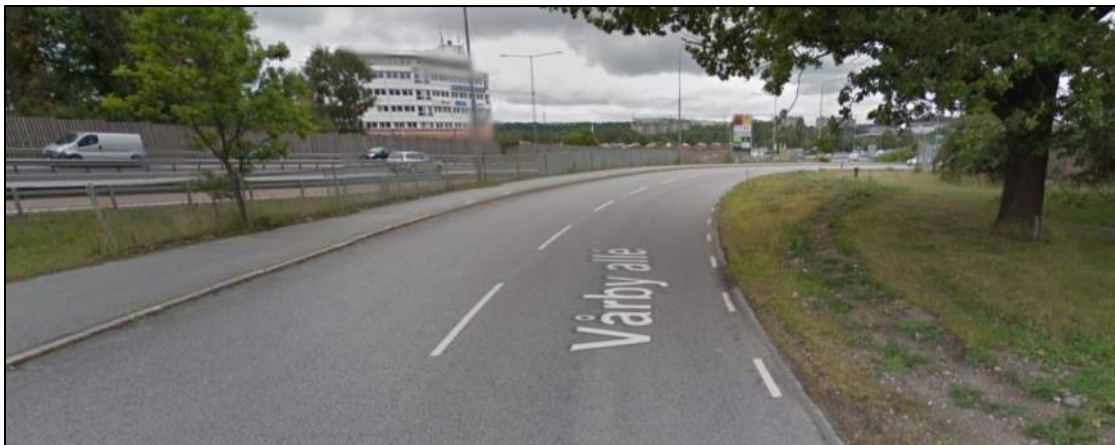
Figur 2-8. Gatuvy i västlig riktning Vårby allé där avrinning från vägen leds till grönyta. Källa: GoogleMaps.
