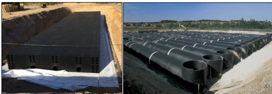
Figur 6-8. Dagvattenmagasin med plastkassetter (t.v.) och i form av rörmagasin (t.h.), hämtat från Stockholms stad (2020a) respektive Stockholms stad (2020b). Plastkassetterna innehåller spolkanaler och rören har möjlighet till nedstigningsbrunnar, som ger åtkomst för exempelvis slamsugning för att avlägsna sediment.
