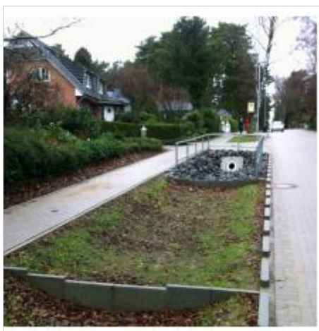
Figur 12. Svackdike med inloppsledning och dämnen. Foto: WRS.
