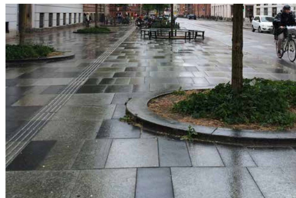
Markbeläggning med inslag av naturstenshällar
