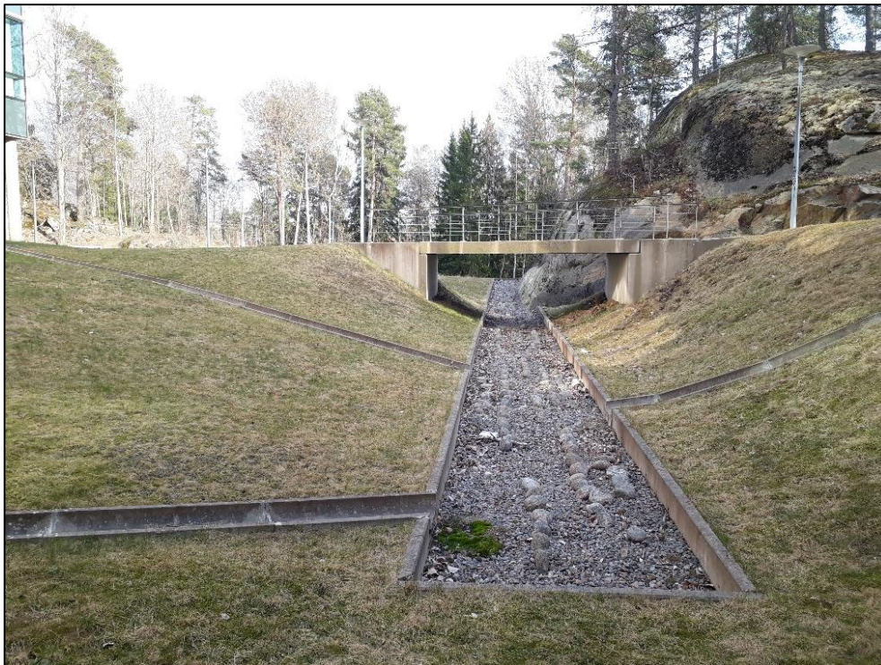
Figur 5. Öppen dagvattenkanal från byggnader norr om planområdet
