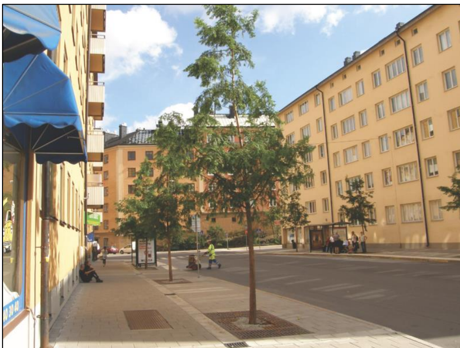
Figur 8. Exempel på trädrad i skelettjord. Dagvatten avleds till skelettjord via dagvattenbrunnar/ luftningsbrunnar.
