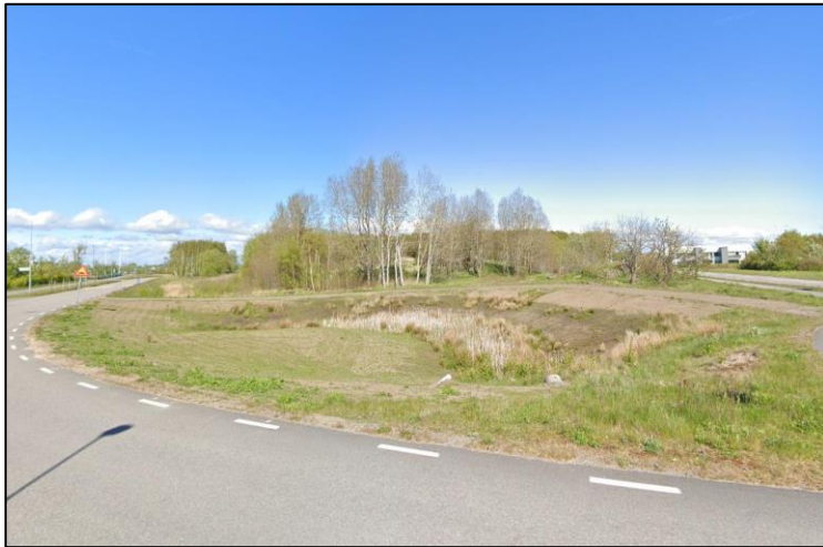
Figur 17. Exempel på hur man kan utforma en torr översvämningssyta. Tångvägen i Träslövsläge, Varberg (Foto: Norconsult)
