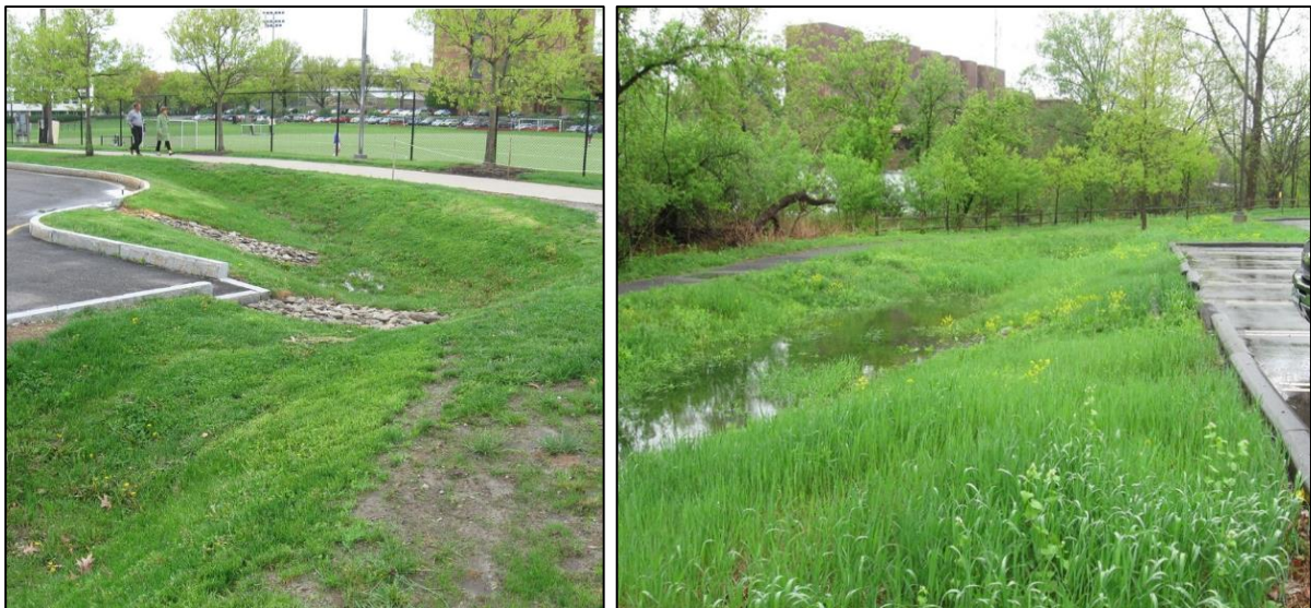
Figur 18. Exempel på torrdammar. Den högra bilden illustrerar hur en torrdamm kan se ut efter ett regntillfälle. (Foton: Lauren E. McPhillips, Penn State)
