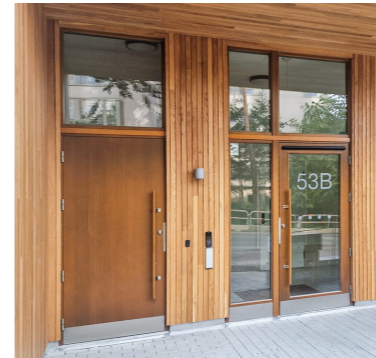
Entrépartier i trä
