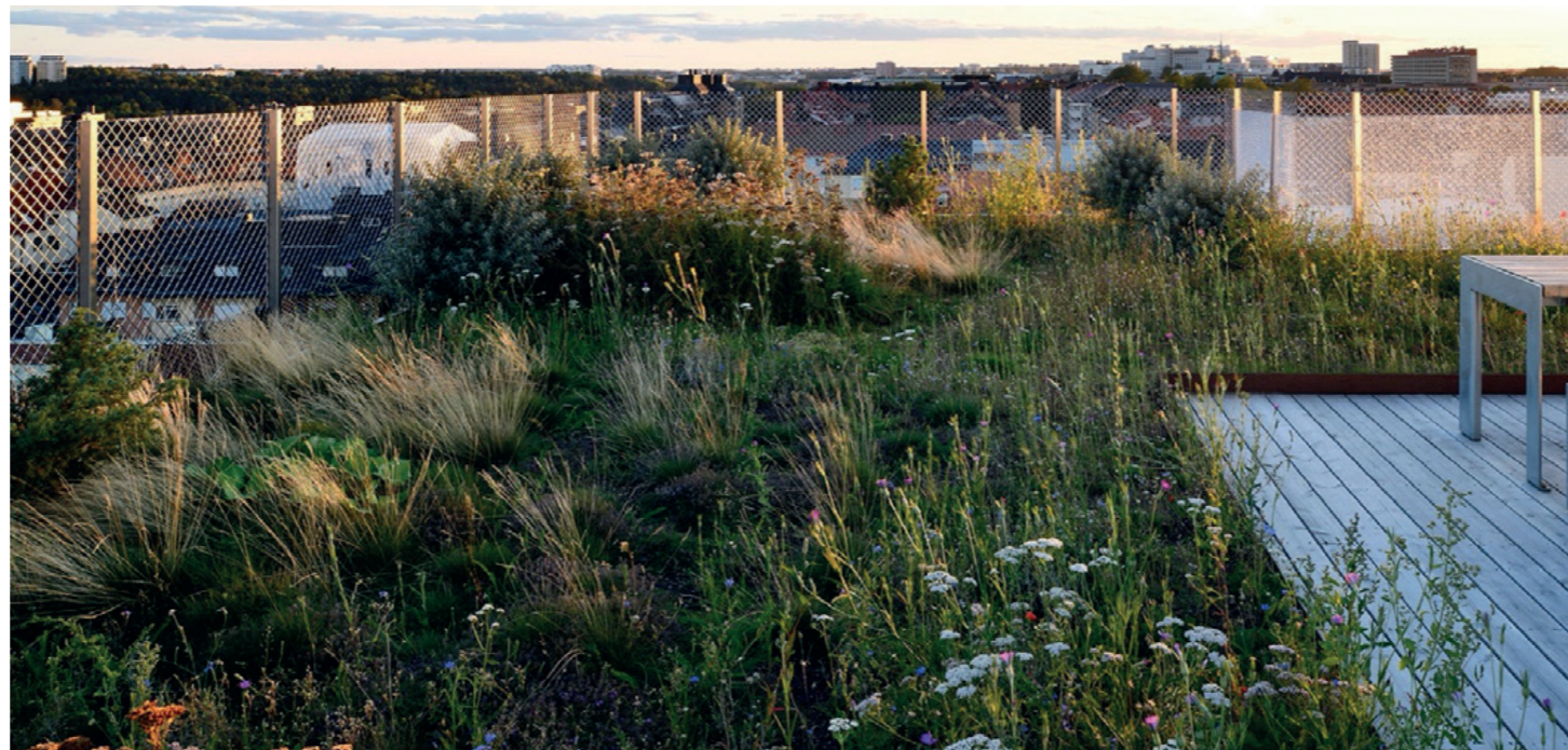
Bild ovan: Takvegetation med buskar, gräs och örter, Urbio
