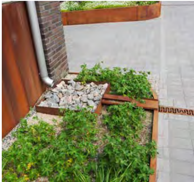
Regnvatten från tak led ned till gård. Infiltration stärker grundvattnet, minskar risken för översvämning och ger friskare grönska
