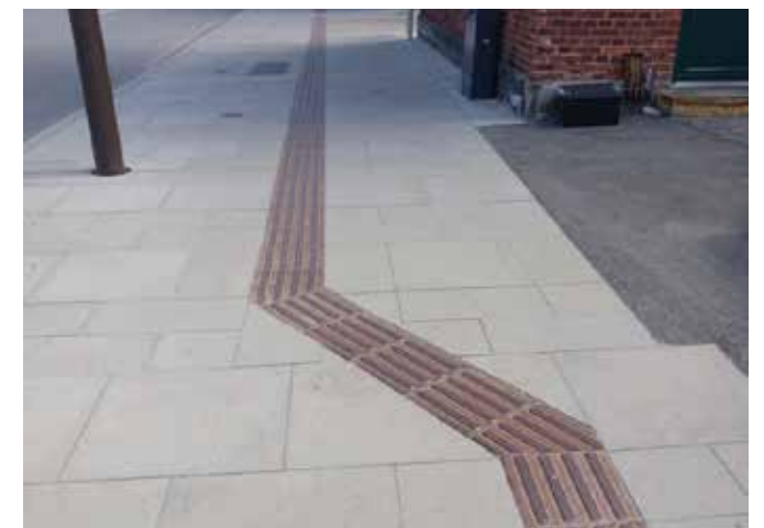
Där bilar tillåts korsa torget, utförs ledstråk i robust material. Markmaterialet är enhetligt, men nyanser kan variera för att förtydliga var bilar (angöring, RHP) tillåts köra.
