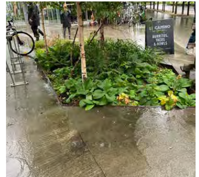
Regnbäddar ger funktionell och dekorativ grönska, samtidigt som de är en central del i LOD - Lokalt Omhändertagande av Dagvatten. Upphöjda kantstenar undviks, eller nollas lokalt, för att släppa in vattnet.
