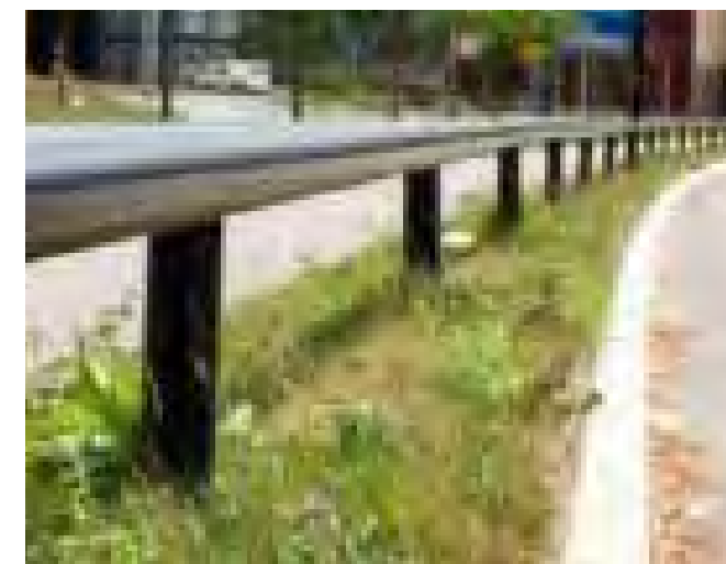
Parkeringsräcke av stålror, pulverlackat, c/c-avstånd stolpar 2,5 m linjeras med linjering för P-plats
