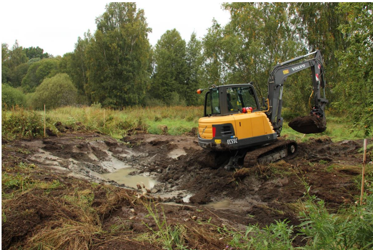
Figur 15. Pågående arbete med att anlägga en ny damm vid Skönstaholmsfältet i Stockholm
