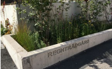
Regnbäddar för infiltration och fördröjning av dagvatten
