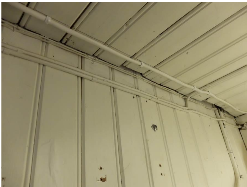
I det gamla kapprummet finns ursprunglig pärspontpanel på väggar och i tak.
