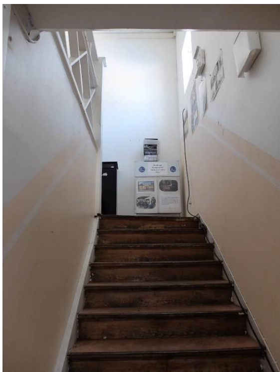
Ursprunglig trätrappa med linoleumsteg till övervåningen. Sockellister i trä. Kryssformat trappräcke i trä på övervåningen.
