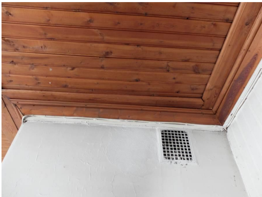
Murstock med ventilationsgaller, original från 1920-talet. Tak med taklist i spontad furu, sannolikt också ursprungligt.
