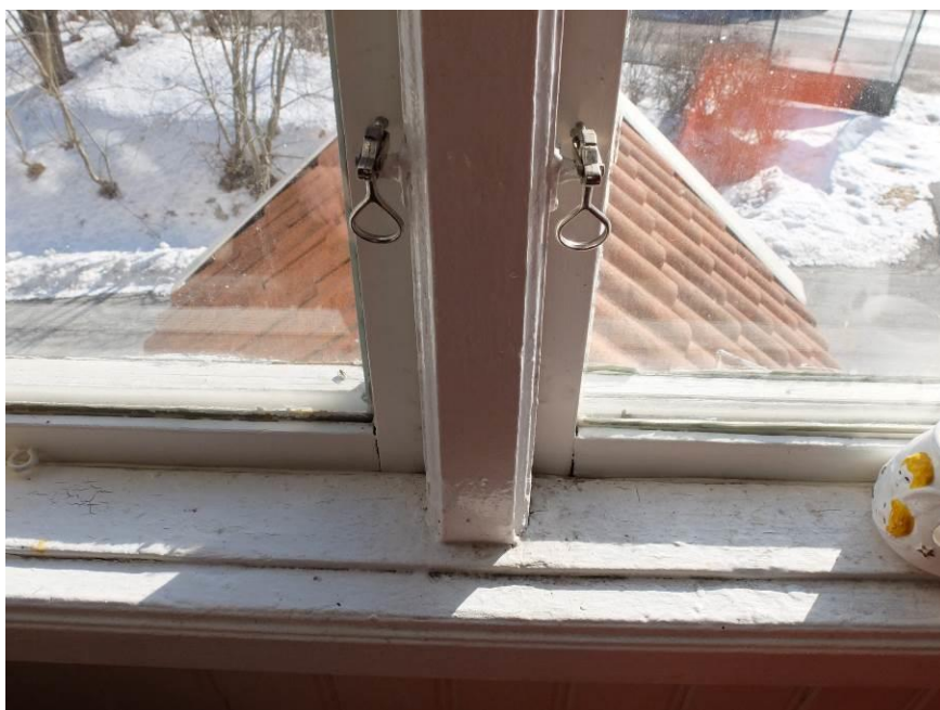
Ursprungliga träfönster med senare haspbeslag i äldre stil.
