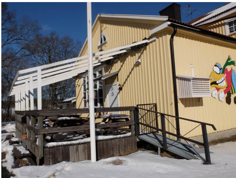
Gavelfasaden mot väster är tillbyggd med en veranda med anslutande ramp. Entrén på den västra gaveln är sekundär, ursprungligen fanns här fyra fönster till klassrumssalen, liksom på den östra gaveln.
