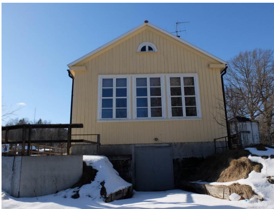
Den östra gavelfasaden med infart till verkstad i källarvåning. Källaren grävdes ut på 1940-talet. I övrigt är fasaden bevarad i ursprunglig karaktär med renoverade originalfönster.
