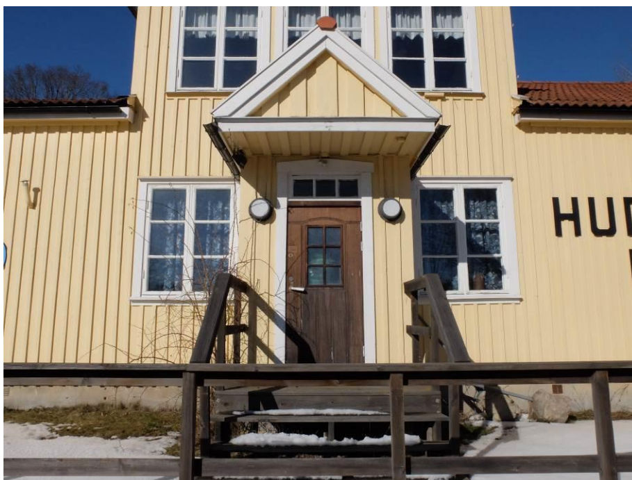
Entré på den södra fasaden, mot vägen. Ursprungligt dörrfoder och överljus, dörren är senare tillkommen, troligtvis 1970-tal. Trappa och räcken är utbytta. Ursprungligen bars farstuvistens tak upp av träpelare på var sida och trappan omgavs av kryssräcken i trä.
