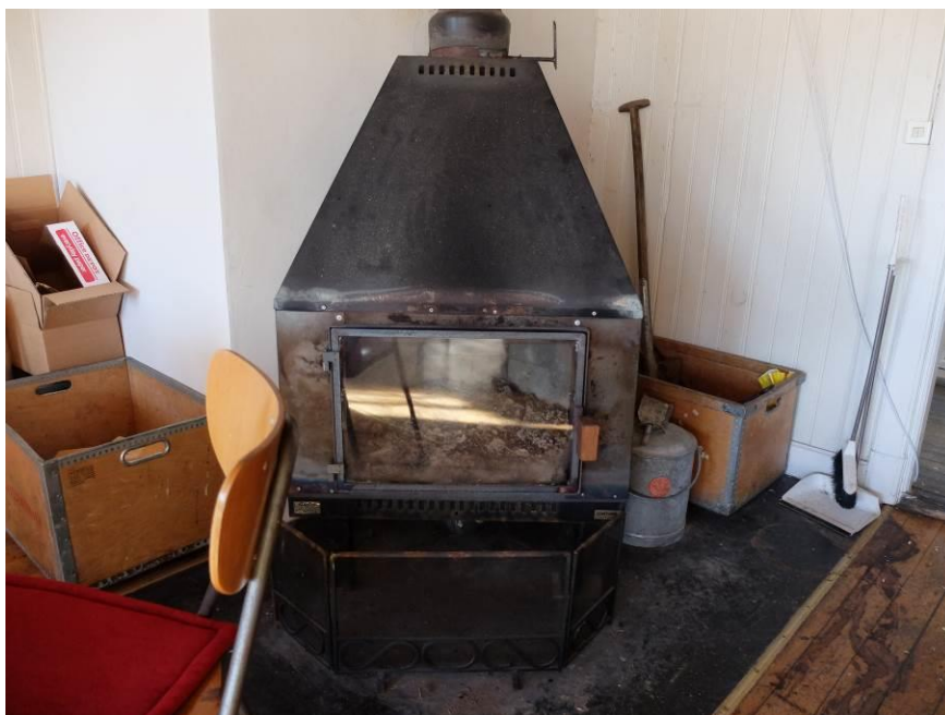
Braskamin, troligtvis från 1980-talet, med gnistskydd och eldstadsplan. Bakom syns den putsade murstocken och pärlspontpanel.
