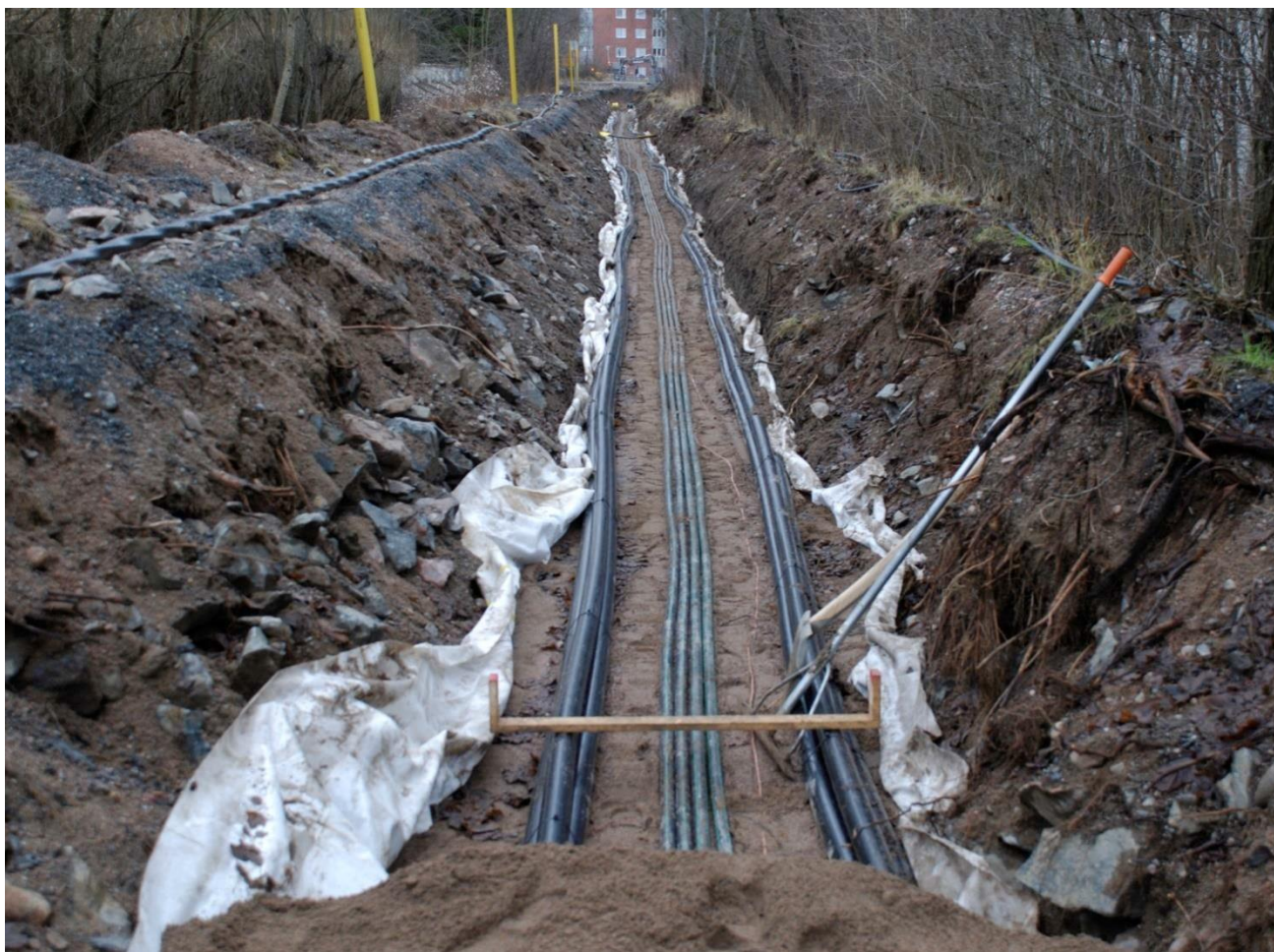
Figur 8. Exempel på kabelschakt.
