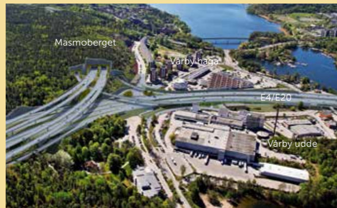
Tvärförbindelsen Södertörn sett från norr. Närmast till höger i bild ser vi det tidigare bryggeriet där Vårby udde nu utvecklas och ovanför motorvägen ser vi Vårby haga. Källa: Trafikverket.
