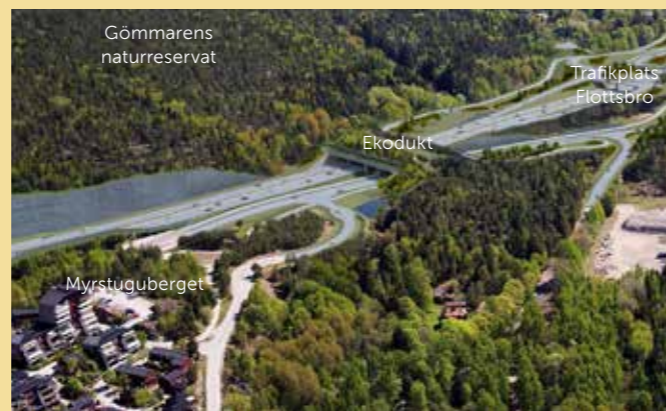
Tvärförbindelsen Södertörn sett från väster vid Myrstuguberget, vilket skymtar i nedre vänstra hörnet. Källa: Trafikverket.
