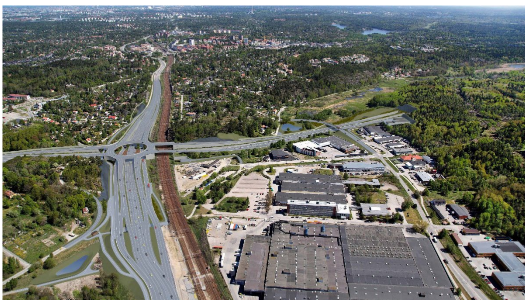
Figur 6: Vy mot trafikplats Vårdkasen. Bild: Trafikverket.
