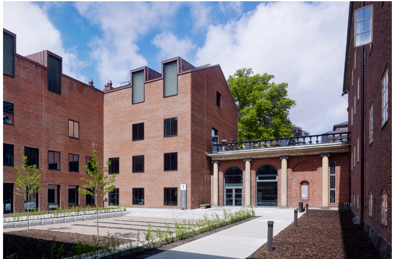
Tillbyggnaden av Carlanderska sjukhuset är ett bra exempel på hur modern arkitektur kan inspireras av den bebyggelse som redan finns på platsen.
