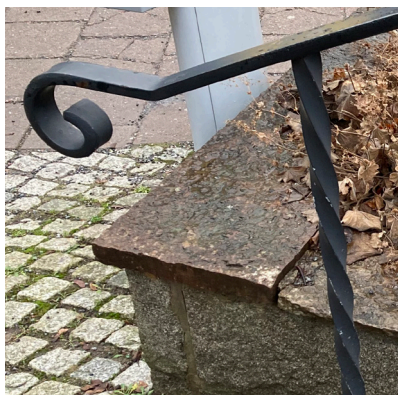
Tidstypiska handräcken i svart smide. Stödmur med krönsten
