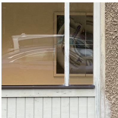
Fönster med bågar och omfattningar i trä i vit kulör. Bröstning i vit panel.
