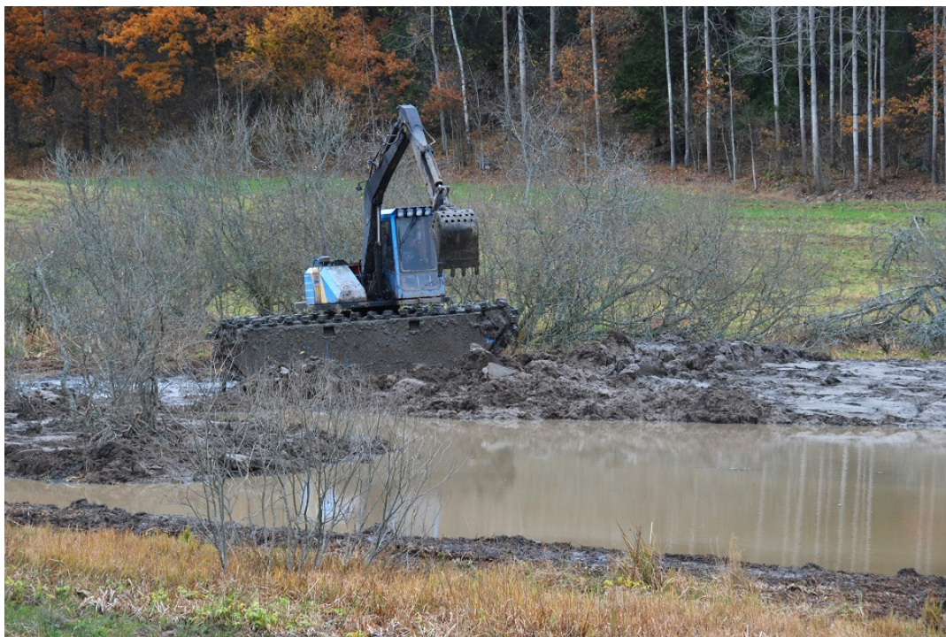
Grävning av våtmark vid Långängen i Ornlångens naturreservat. Foto Richard Vestin.
